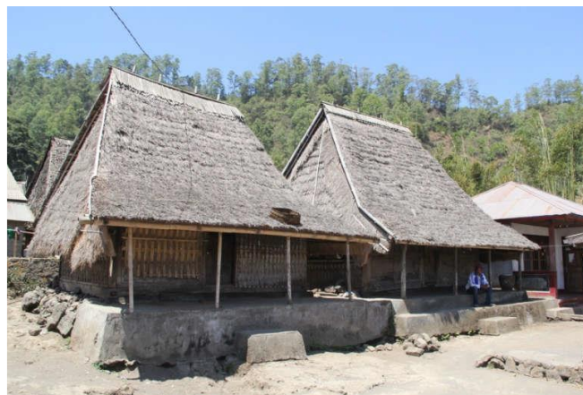
Gambar 3: Bangunan Saka roras Desa Belandingan Sumber : survey, 2018
